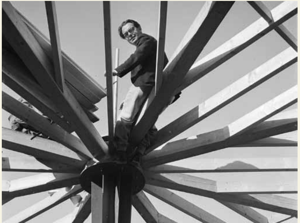
Der Architekt Max Frisch auf der Baustelle des Freibads Letzigraben in Zürich, 1948. (Bild: Max Frisch-Archiv)
